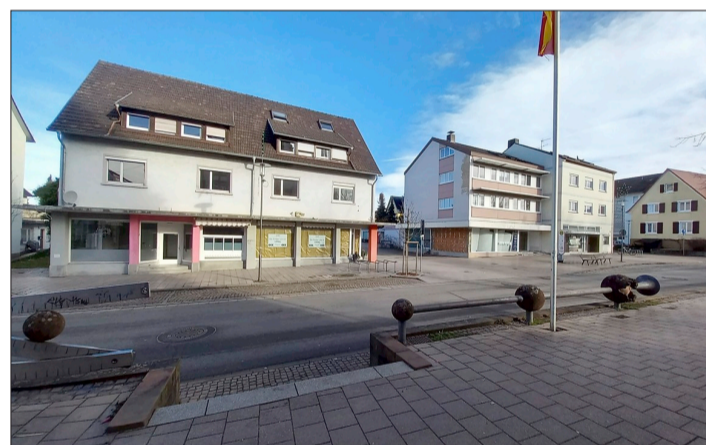
Diese drei Häuser gegenüber dem Alten Denzlinger Rathaus werden demnächst abgerissen und durch Neubauten ersetzt. Foto: Helmut Gall
